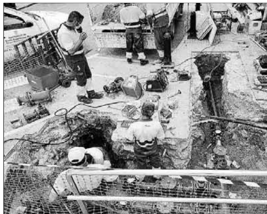
Operarios de Aqualia trabajando en Santa Eulària.
