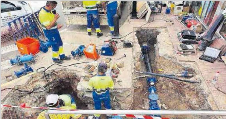
Operarios de Aqualia durante una de las obras contempladas en el proyecto.
